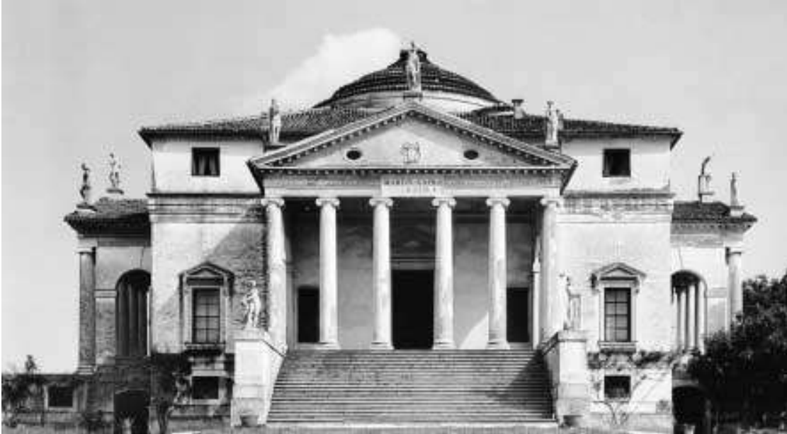
Obra 4: Villa Rotonda , d'A. Palladio.
