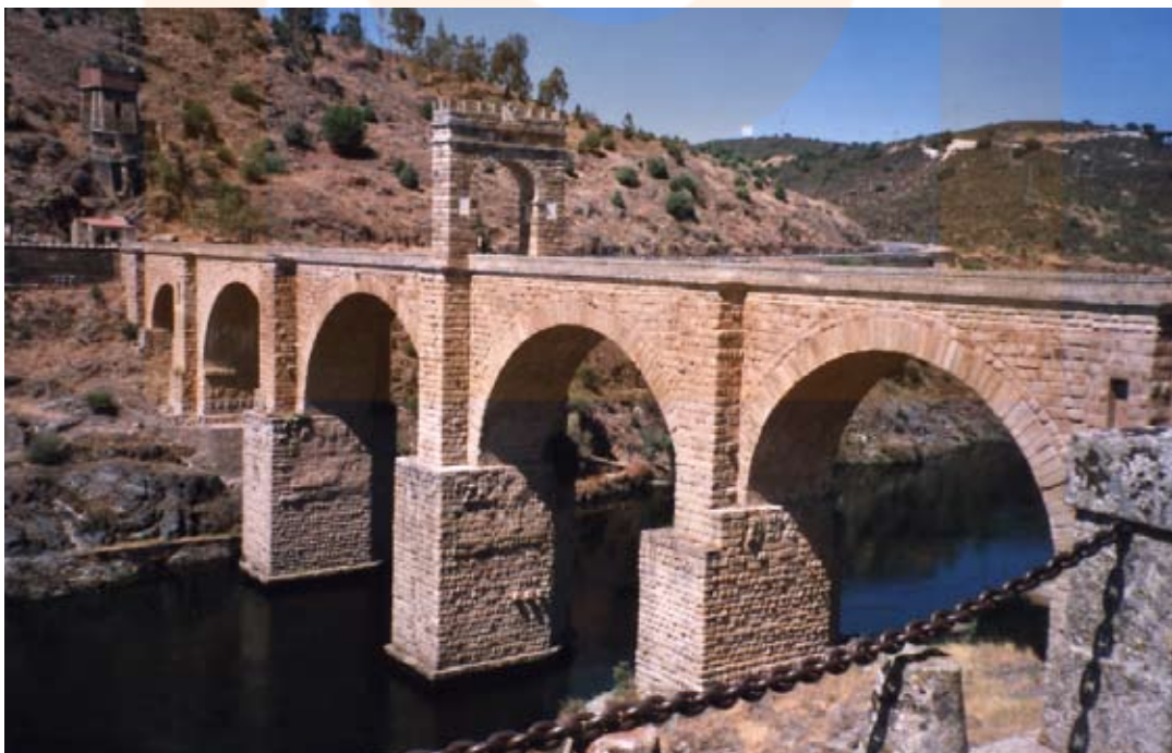
7.25 Pont d'Alcàntara sobre el riu Tajo (Cáceres)
