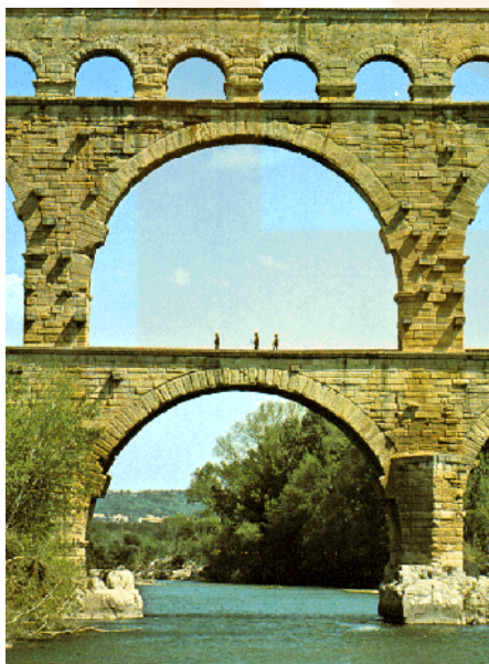
7.19 Aqüeducte de Pont du Gard (França)
