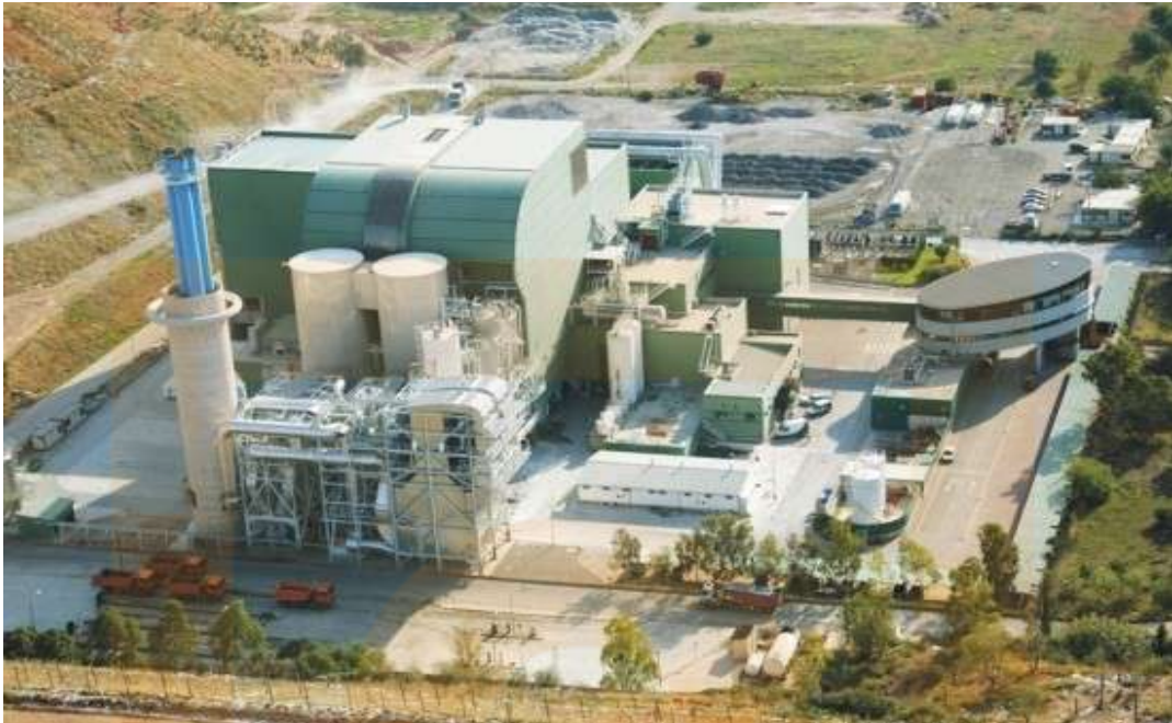
Planta incineradora de residus de Mallorca.
