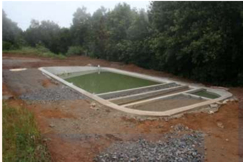
Vista aèria d'una estació depuradora d'aigües residuals
