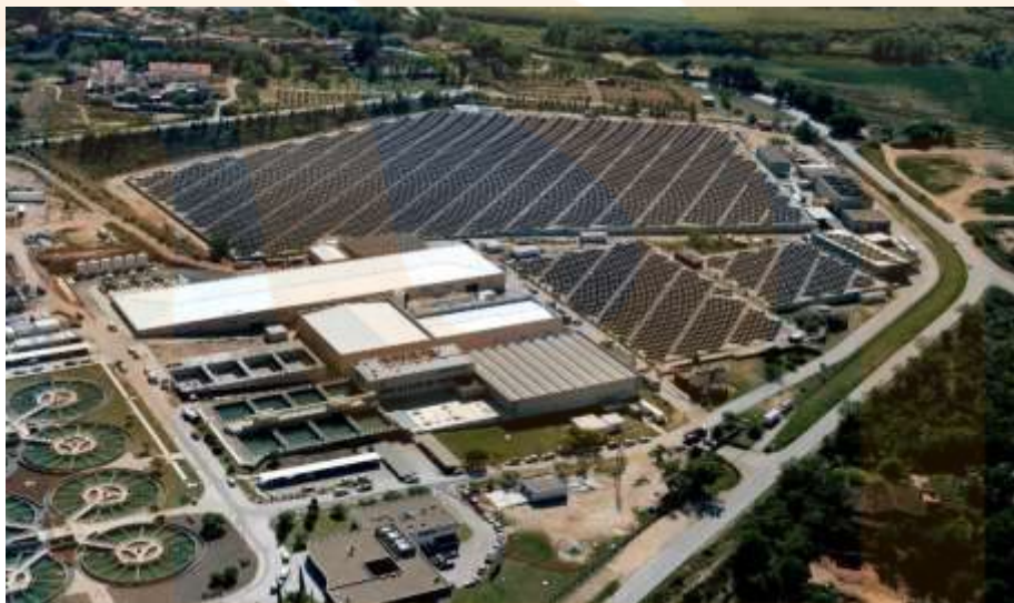
Vista aèria de la planta potabilitzadora d'Abrera, Baix Llobregat, Catalunya
