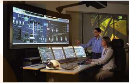
Sala de control d'una cèl·lula de fabricació flexible
