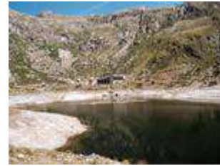
El pantà de Sallente que alimenta la central hidroelèctrica d'estany Gento-Sallente
