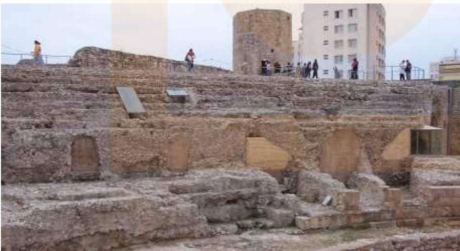
Cauea de la capçalera del circ
