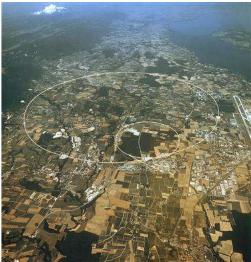
Figura 2. Vista aèria de la frontera entre França i Suïssa on es troba el CERN. En la fotografia es veu superimposada la traça del túnel, de 27 km de longitud i a 200 m de profunditat, on s'ha instal·lat el LHC (Font CERN)
